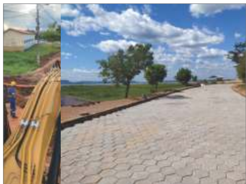
Obras de saneamento avançam em Babaçulândia, melhorando a qualidade de vida da comunidade
