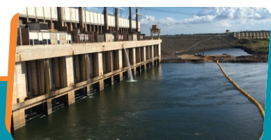
Pag. 04 - Instalada barreira física para isolar Área de Segurança da Usina
