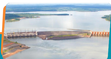
Pag. 03 - Estiagem prolongada reduz a vazão da Usina Hidrelétrica Estreito
