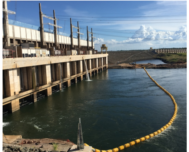
Barreira de proteção tem 315 metros de comprimento e protege, de uma margem à outra, a Área de Segurança da Usina
