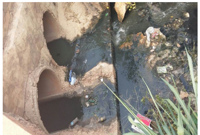
Projeto fará o tratamento dos efluentes despejados no Lava Caras
