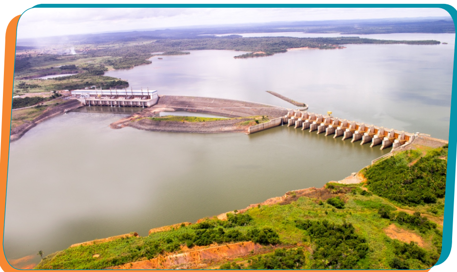
Em operação desde o mês de abril de 2011, a Usina Hidrelétrica Estreito é um empreendimento fundamental para o desenvolvimento socioeconômico do Brasil
