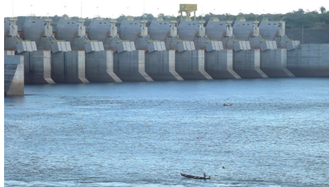
Presença de barcos em local proibido coloca em risco a vida das pessoas
