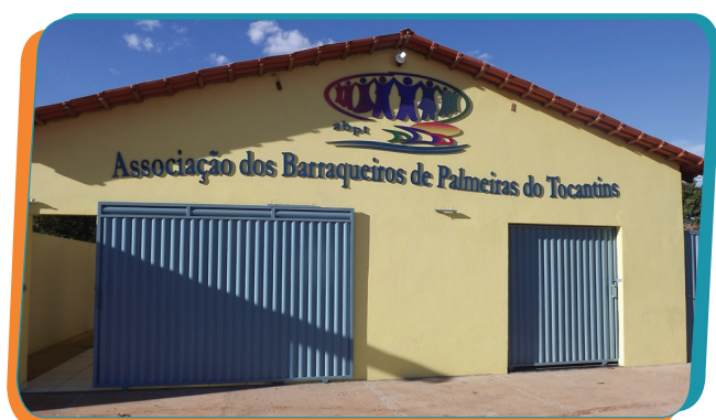
Construção da sede própria da Associação dos Barraqueiros de Palmeiras do Tocantins/TO é mais uma das obras do ISE
